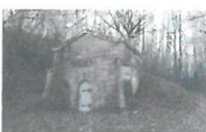
Réservoir communal de Wihr-au-Val 1904
